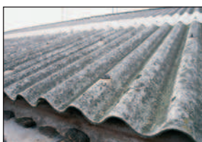
© INRS Toiture en amiante ciment
