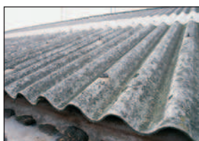
© INRS Toiture en amiante ciment
