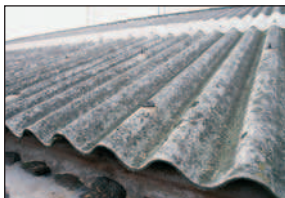
© INRS Toiture en amiante ciment
