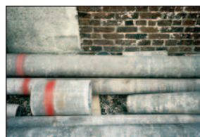
Crédits : INRS Canalisation en amiante ciment
